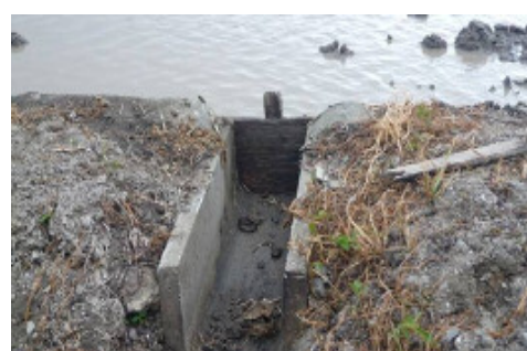
適切に止水された状況
