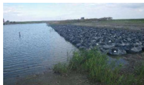
写真 3-7 上水場発生土 中央遊水池への設置状況
