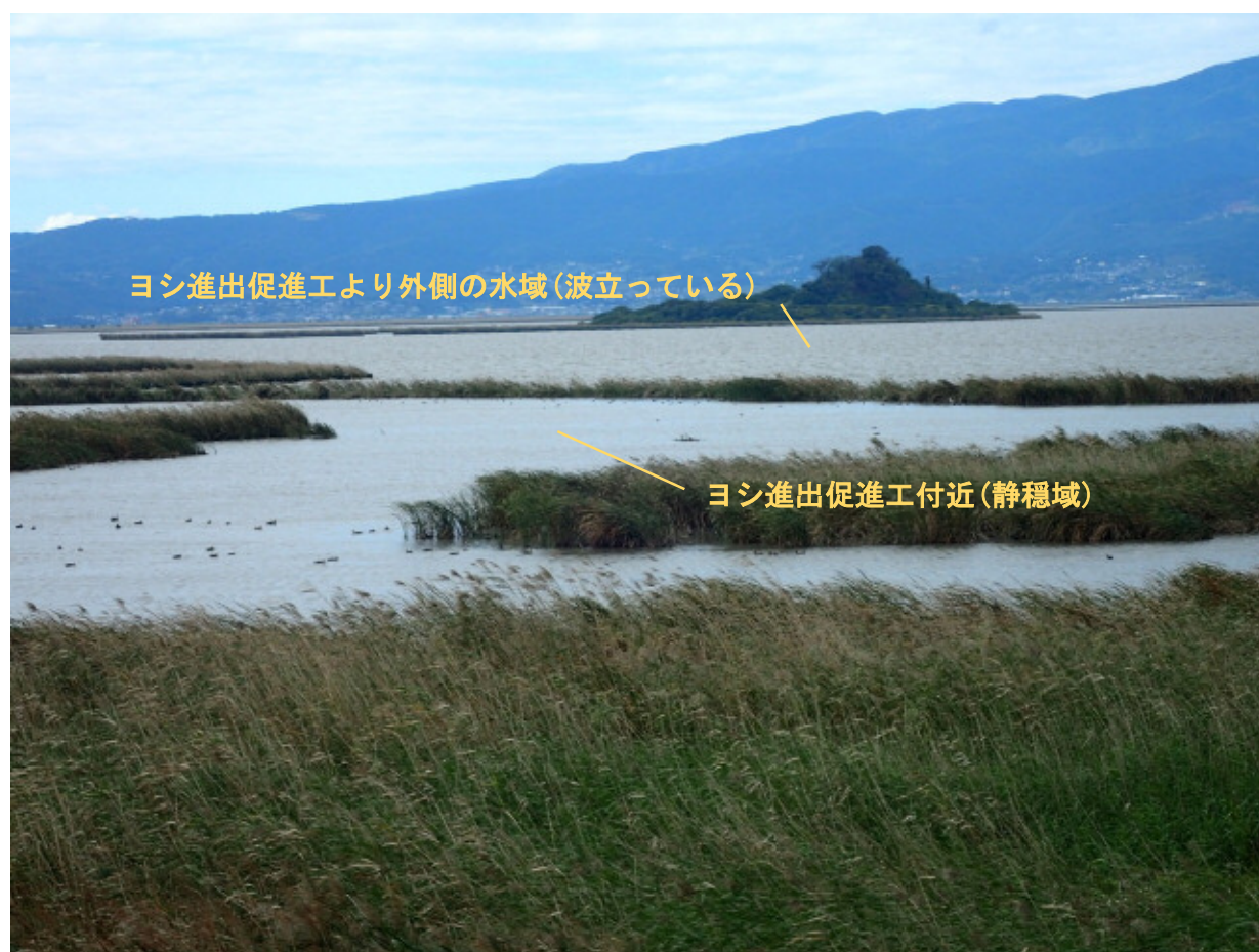
写真 3-3 風が強い日のヨシ進出促進工付近と外側水域の波高の比較
