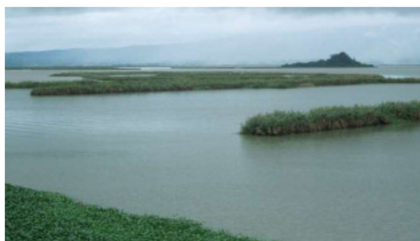
写真 3-2 ヨシ進出促進工の設置状況
