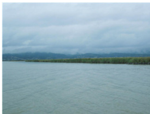
写真 3-1 潜堤の設置状況
