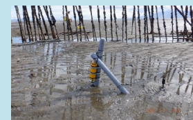
〔波浪防止柵の設置〕
