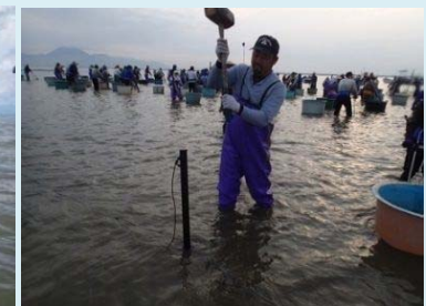
被覆網設置の様子
