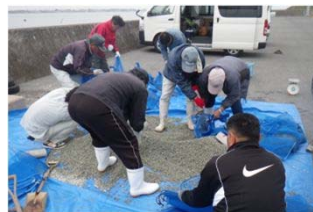
基質（細かな砂利）の収容作業と網袋設置作業
