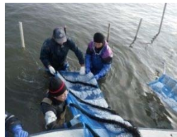
②クラムマット設置状況
