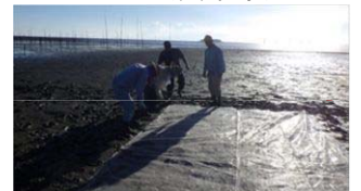
[写真4] 被覆網の設置状況(福岡県)
