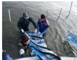
②クラムマット設置状況
