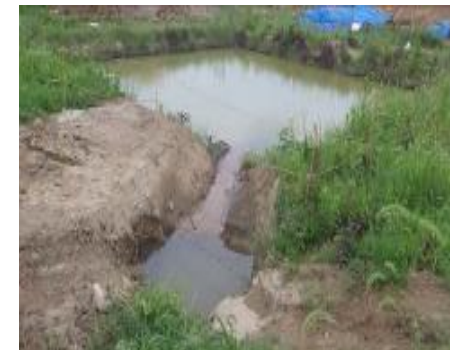
土砂流出防止対策沈砂池
