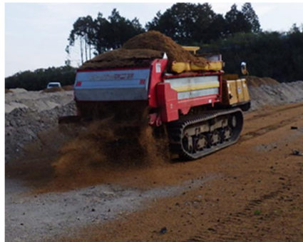
バーク堆肥散布状況
