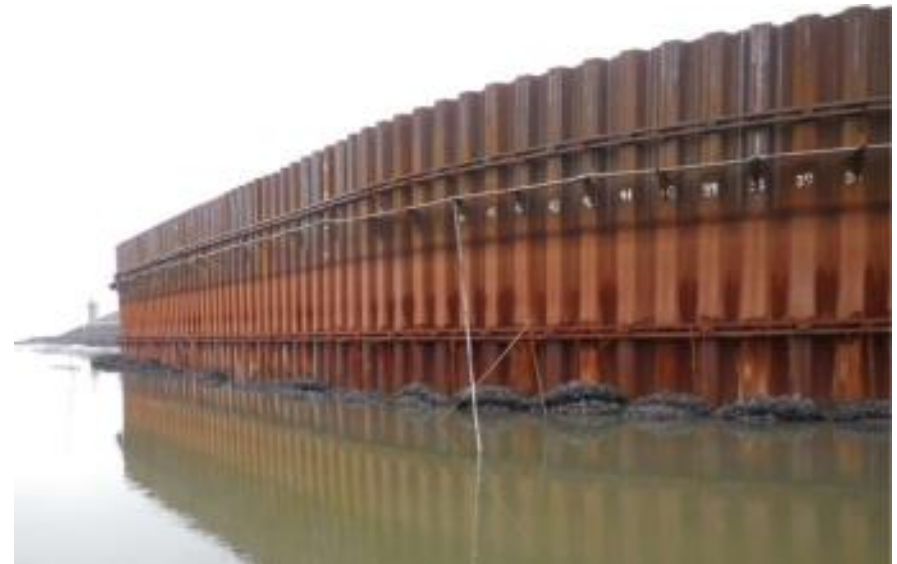
ハット型鋼矢板の施工完了状況
