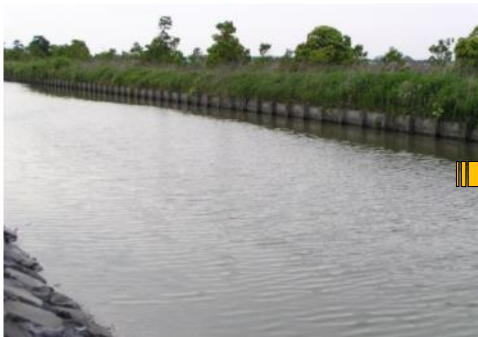
コンクリート製品での護岸
