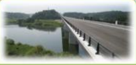
⑤国道208号バイパス
