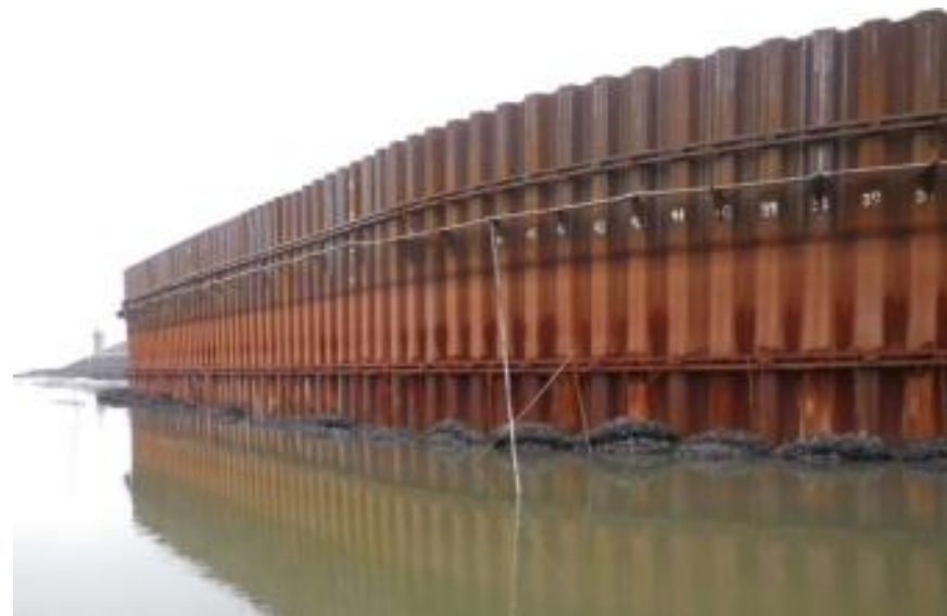
ハット型鋼矢板の施工完了状況
