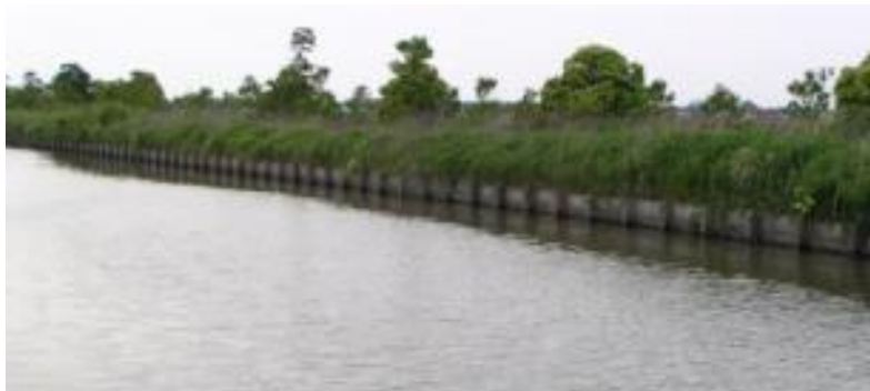
コンクリート製品での護岸
