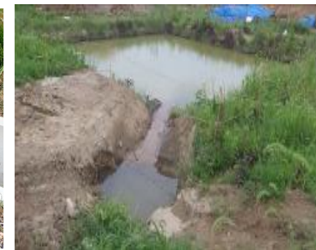
土砂流出防止対策沈砂池
