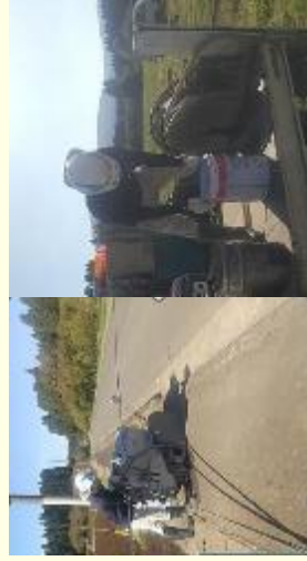
舗装切断（濁水・汚泥処理）
