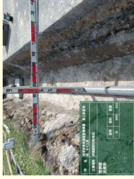
管水路の浅埋設（標準断面図及び管水路設置状況）
