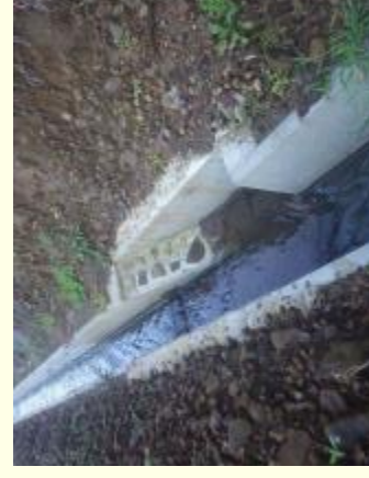
這い上がり付き水路
