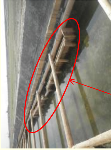
環境配慮木柵工
