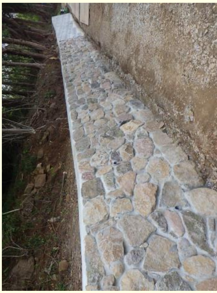
石積み施工状況(手前側:石積み、奥側:ブロック積み)
