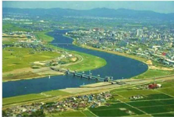
筑後大堰を望む
