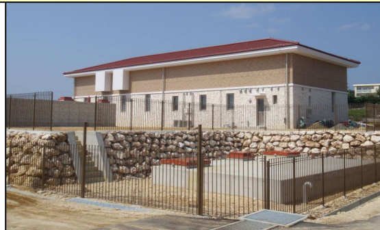
現場発生材を再利用して石積を造成した余多揚水機場
