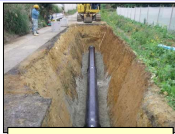
パイプラインの道路下埋設
