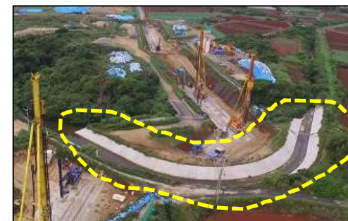
施工中の余多川仮回り水路
