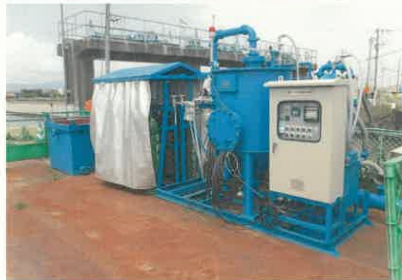
中和処理施設の設置
