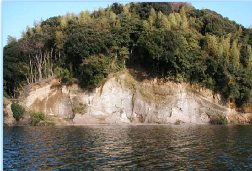
ダム法面崩壊部
