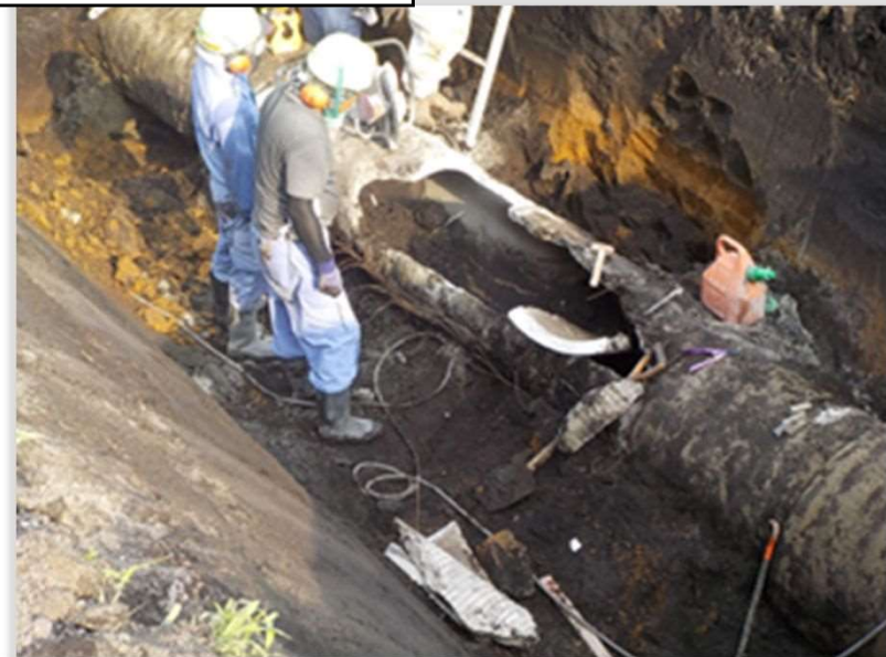
老朽化による管体破損状況
