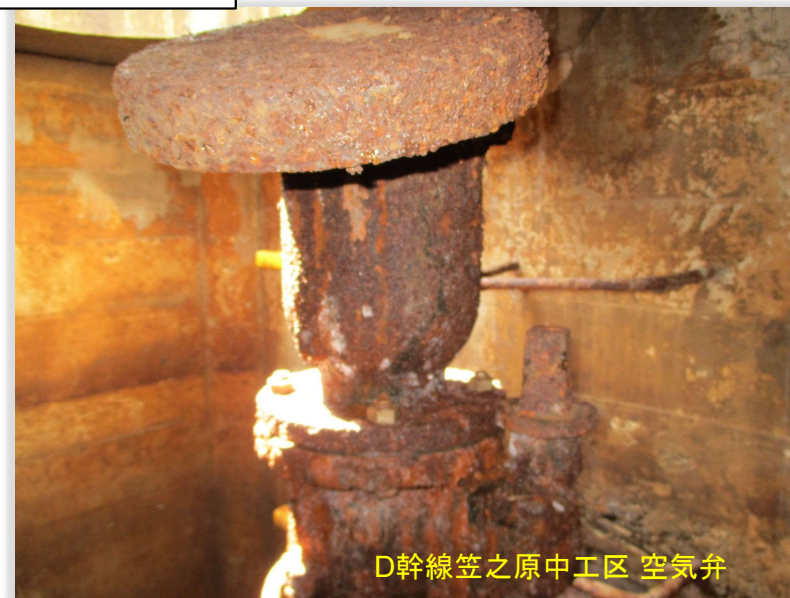
空気弁の老朽化②
