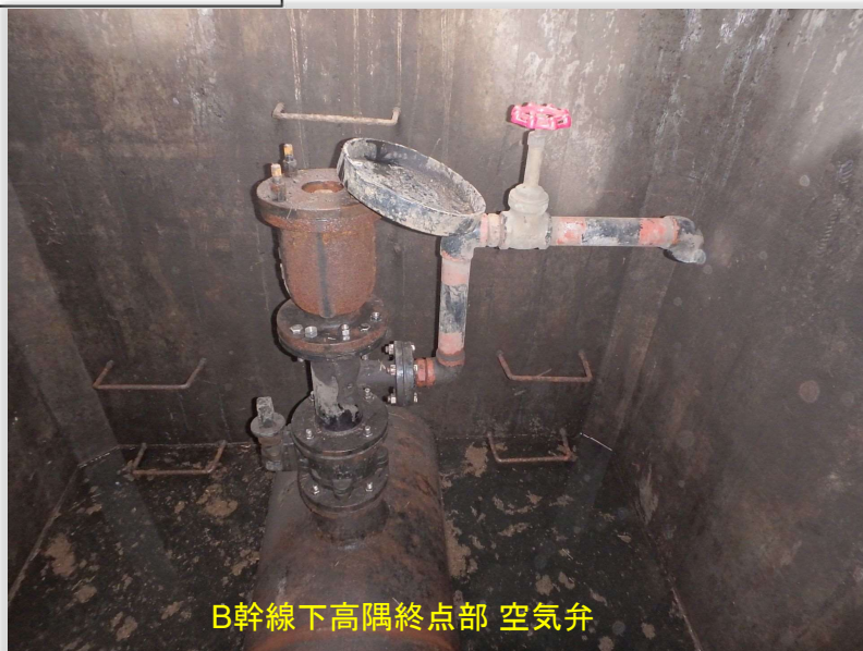
空気弁の老朽化①
