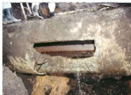
管破損による漏水（幹線水路）
