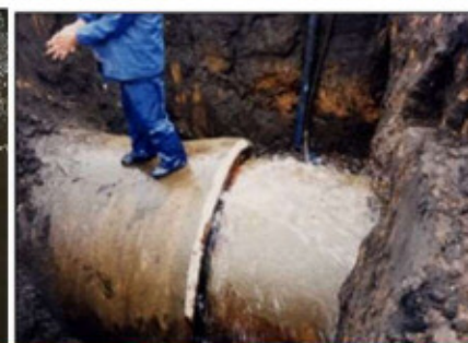
継目からの漏水（幹線水路）
