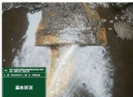
継目からの漏水（幹線水路）
