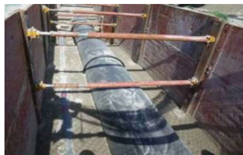
幹線水路改修状況
