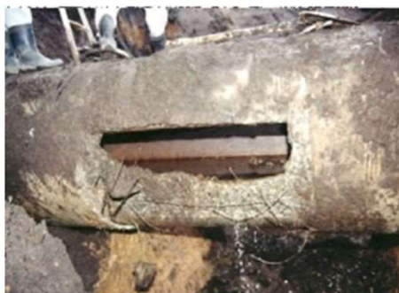
管破損による漏水（幹線水路）
