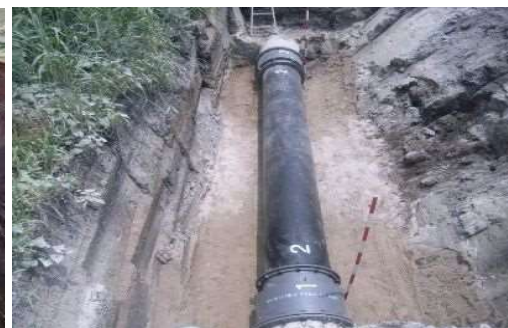
漏水補修状況（幹線水路）
