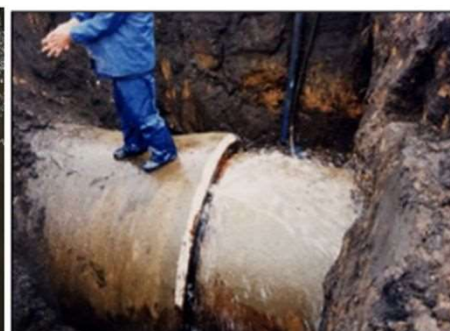
継目からの漏水（幹線水路）
