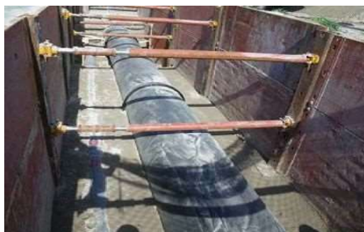
幹線水路改修状況
