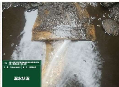
継目からの漏水（幹線水路）
