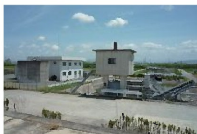
排水水門（前歴事業実施後）
