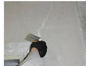
コンクリート構造物のひび割れ
