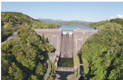
国営嘉瀬川上流総合農地防災事業(北山ダム)
