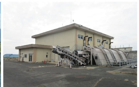
筑後川下流福岡国営施設機能保全事業(谷垣排水機場)
