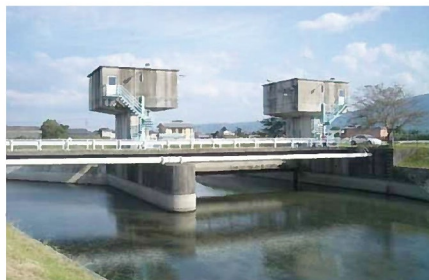
筑後川中流国営施設機能保全事業(雲雀堰)
