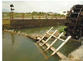
山田堀川用水路 水車と石積み水路
