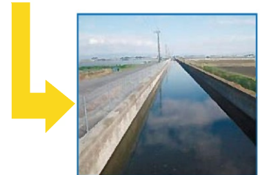
前歴事業により整備された用水路 (床島大刀洗幹線用水路)
