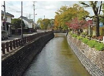
大石南部幹線用水路 白壁土蔵の町並みと石積水路
