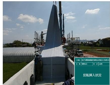
反転材挿入状況（反転工法）
