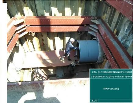
鋼管挿入状況（鞘管工法）
