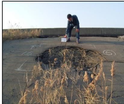
海岸堤防背面の陥没
