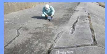
天端被覆工のひび割れ
