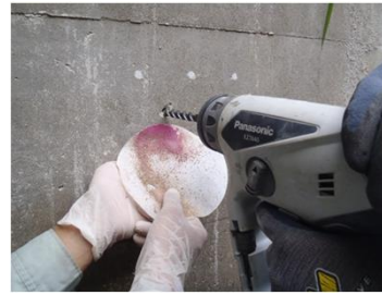
▲コンクリート中性化深さ試験 コンクリートの中性化(内部鉄筋までの残厚)の進行状況を簡易的に測定する試験
