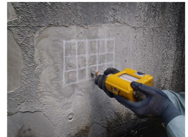
▲反発強度試験 リバウンドハンマーで測定した反発度からコンクリートの強度を簡易的に推定する試験
