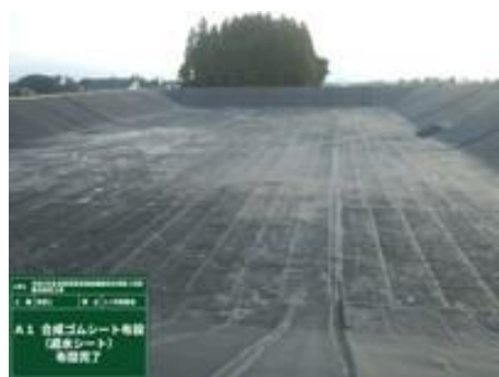
2号調整池遮水シート施工状況
