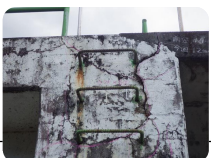
コンクリート施設のひび割れ
