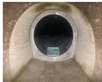
完成した10号隧道補強状況
