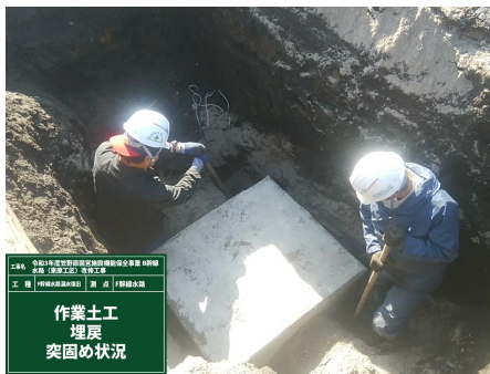
漏水復旧状況 (コンクリート補強工)
