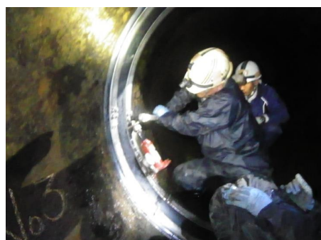
漏水復旧状況 (止水内面バンド工)
