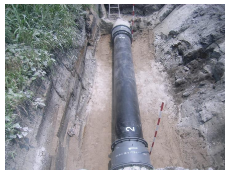
漏水復旧状況 (既設管更新工)
