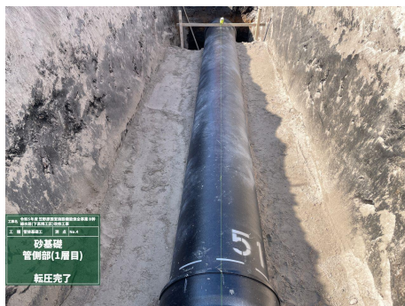
幹線水路更新工事の施工状況 ( \phi 600 ダクタイル鋳鉄管ALW種)
