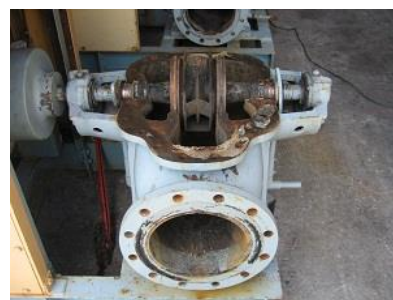
工場で修理中のポンプ
