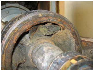
石の噛み込み
