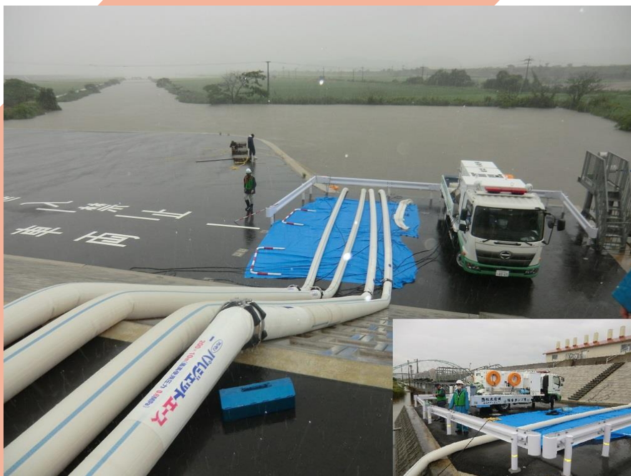
緊急出動した農地冠水被害対応中の排水ポンプ車【福岡県大牟田市 R3.8.13】
