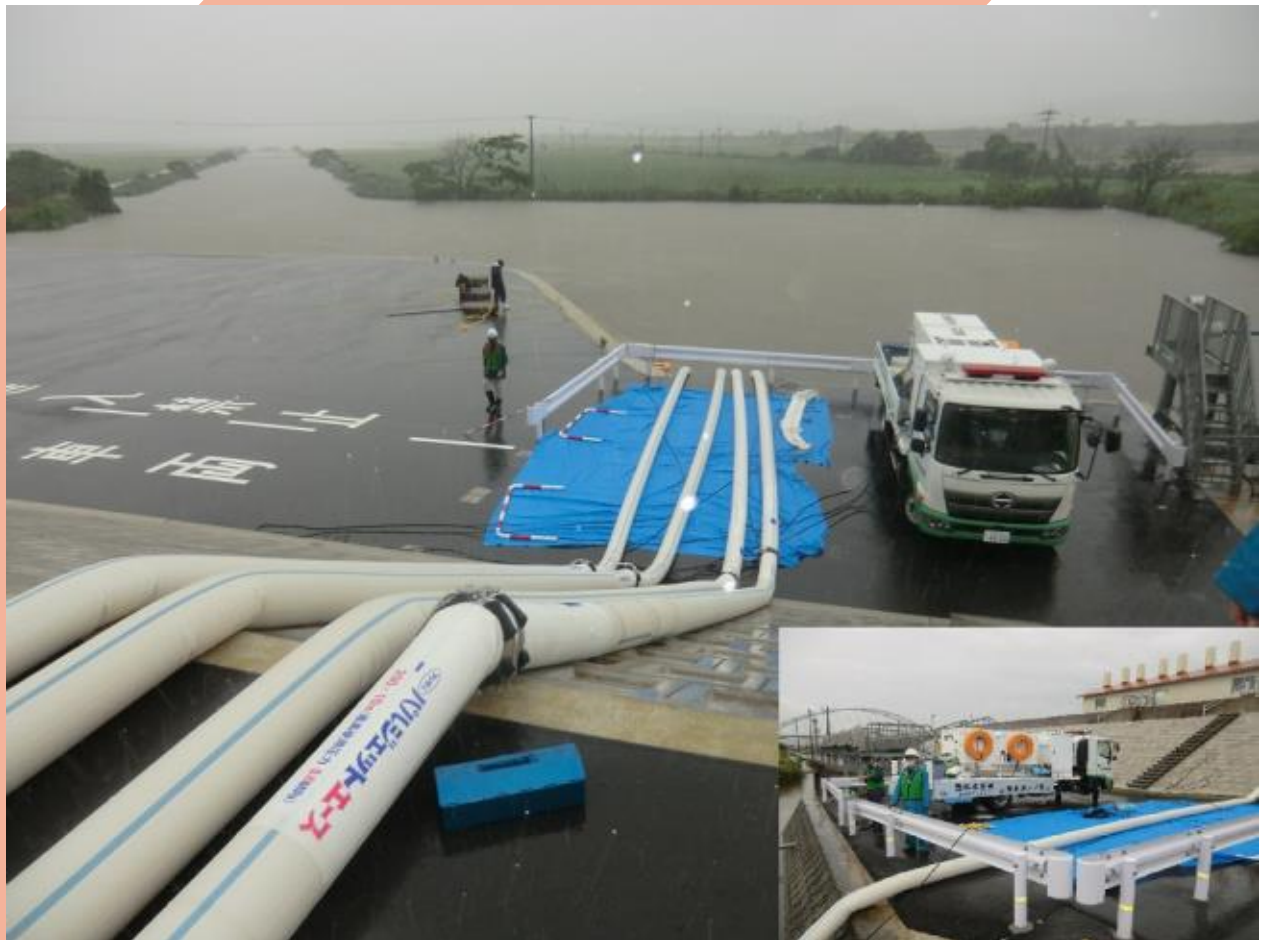
農地冠水被害対応中の排水ポンプ車【福岡県大牟田市 R3.8.13】
