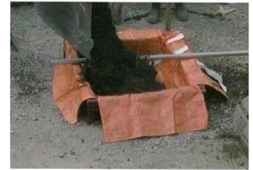
1) D・Boxを専用型枠にセットし上部より中詰め材料を投入
