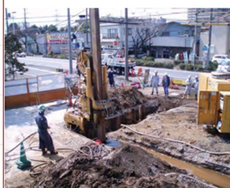
ジェットシートパイル打設状況
