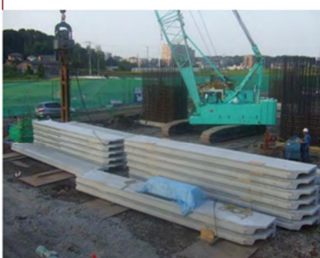
コンクリート矢板打設状況
