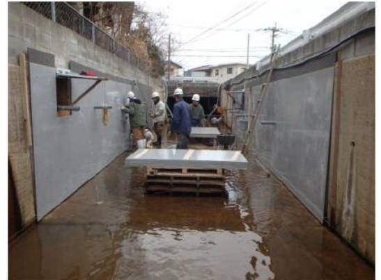
福津市 苅目川雨水幹線改築工事
