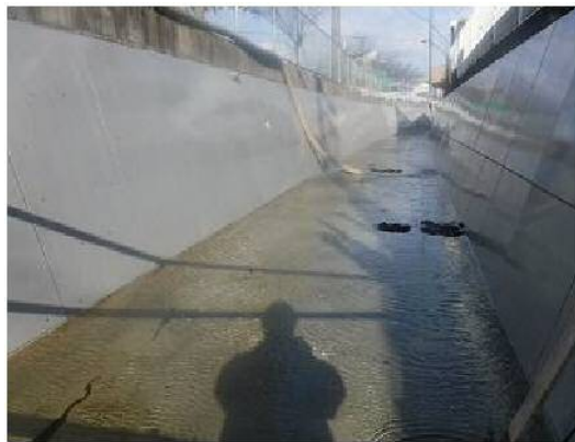
春日市 大和第一雨水幹線改良工事
