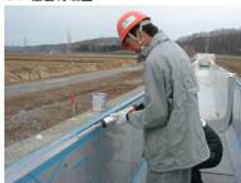
5. シーリング注入
