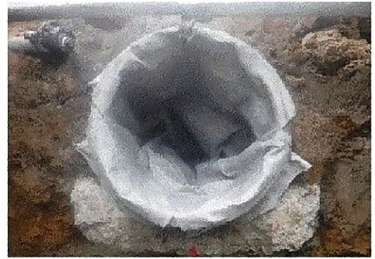
摩擦低減材セット完了
