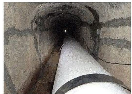
配管後の状況
