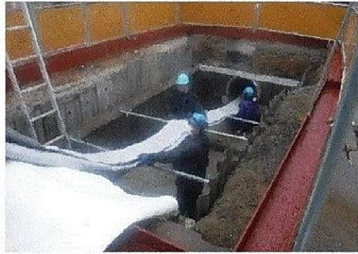
摩擦低減材挿入
