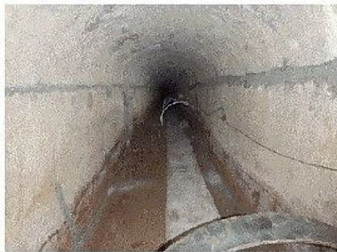
摩擦低減材・管固定材設置状況
