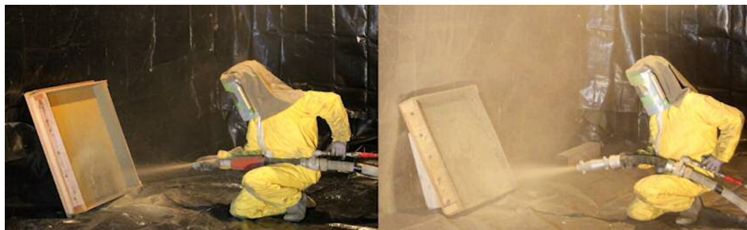
リフレドライショット工法
