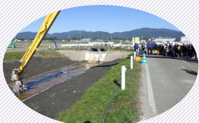
地盤改良工の デモンストレーション
