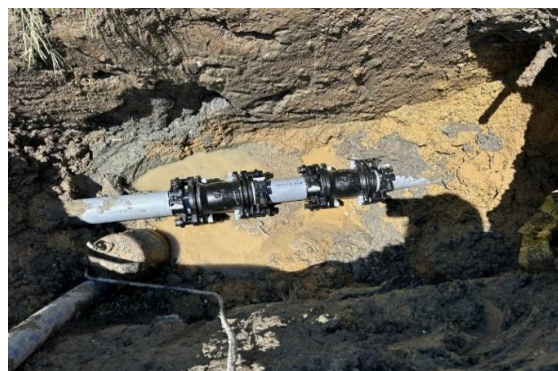
パイプライン漏水の復旧工事
