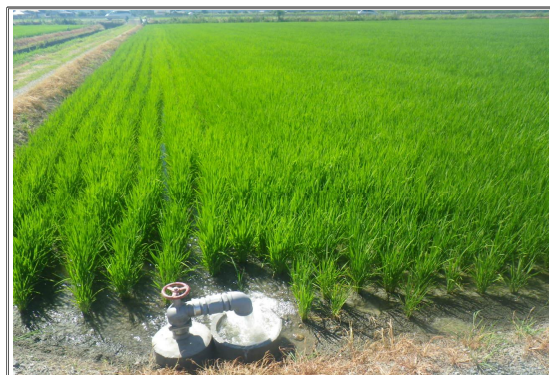
給水栓から田へ注水している様子 (南豊崎工区)
