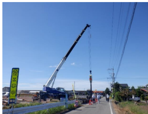
仮栈橋の杭を打っている様子
