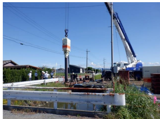
仮栈橋の杭を打っている様子
