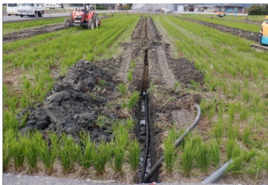
有孔管布設状況
