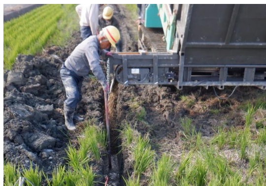
疎水材（ボラ土）投入状況
