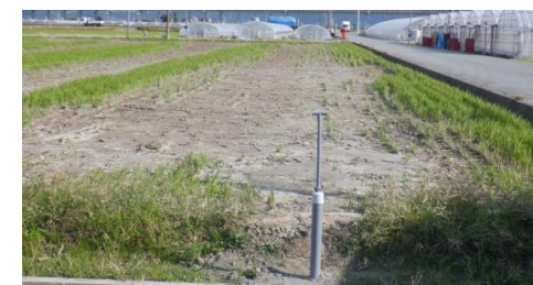
暗渠排水施工後の乾田化の状況
