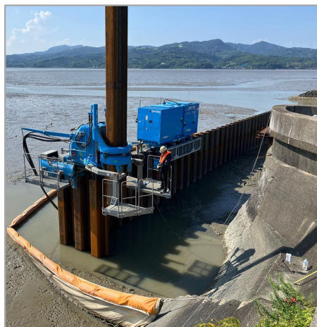
矢板打設の様子
