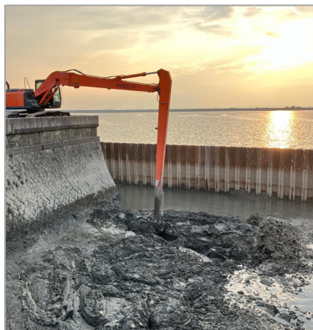
地盤改良の様子
