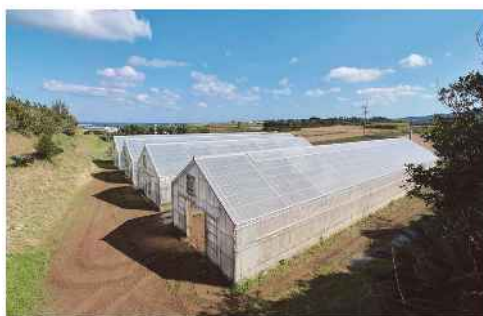
営農支援センターの研修用ハウス
