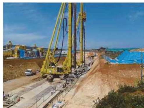
地下ダムの施工状況
