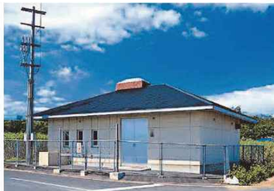
取水施設（集水井）
