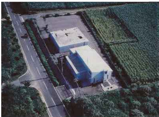
湾頭原揚水機場
