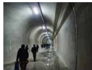
地下ダムのトンネル内の様子
