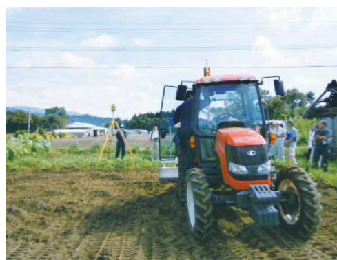
湛水防除のための均平化の様子（綾川二期地区）
