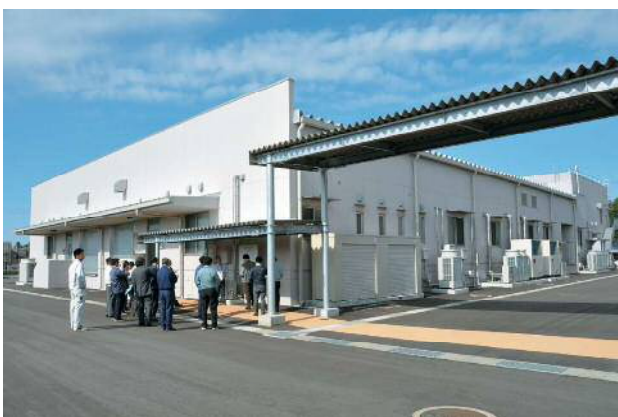
加工ライン実験施設の外観
