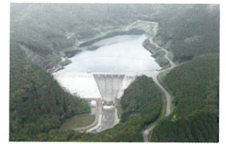
切原ダム（新設）
