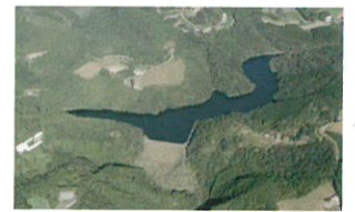
青鹿ダム（改修）
