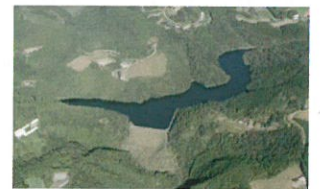
青鹿ダム（改修）
