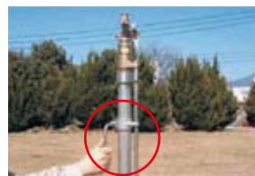
ポップアップライザーと85PK3（赤枠内：締め金具）
